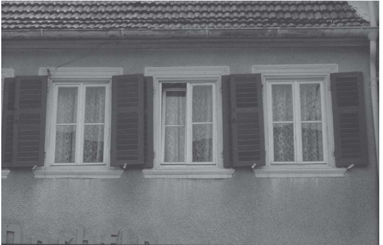
Fenster im 1. Stock des Geburtshauses von Amalia Franziska Rosa Streitl am Rossmarkt in Mellrichstadt
